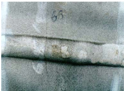
Fig. 6. Esempio di cricca
