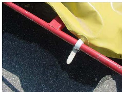
Fissaggio mediante tubolare
