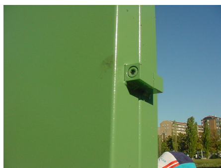
Esempio di apertura carter effettuabile mediante utensile
