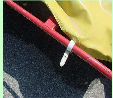
*Esempio di fissaggio del telo mediante tubolare*
