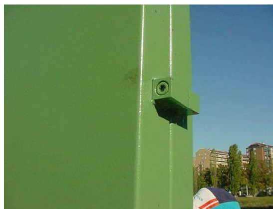
Esempio di carter fisso mantenuto in posizione da un bullone con testa a brugola
