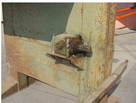
Esempio di presa di potenza non protetta
